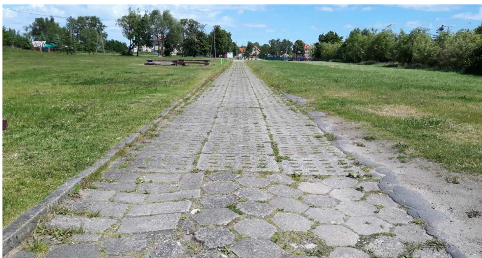
Zdj.2. Istniejąca droga utwardzona przez teren inwestycji.
