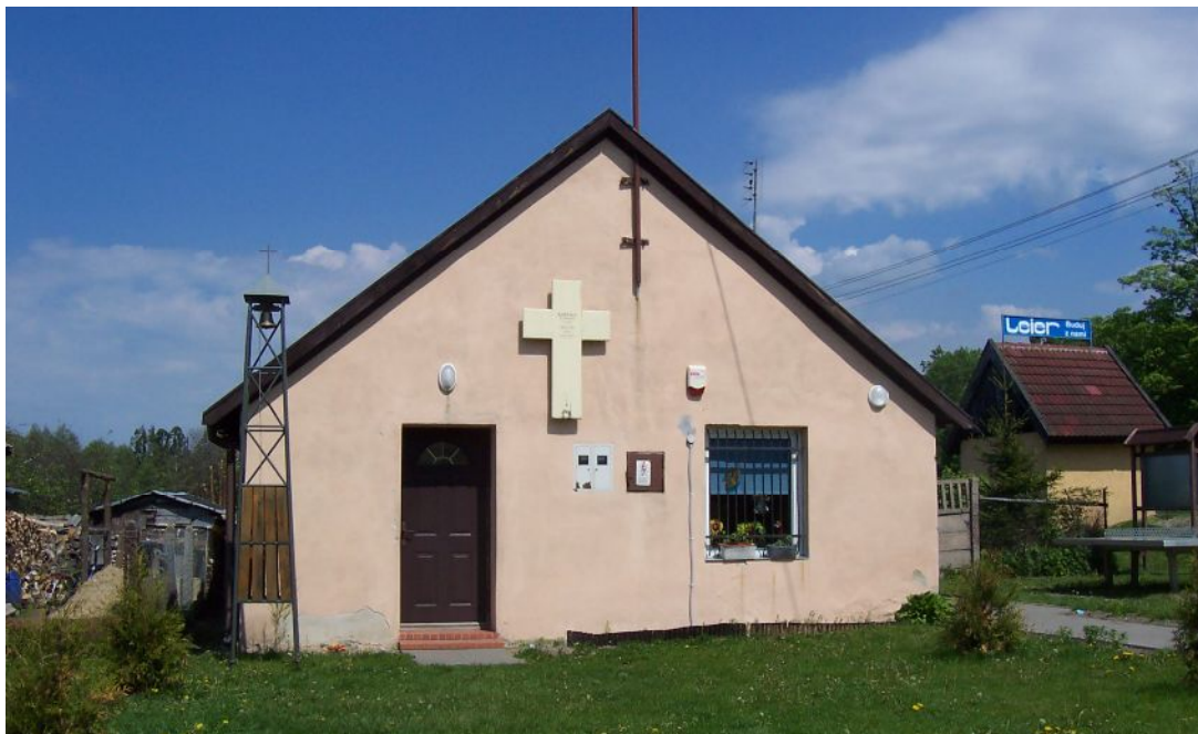
Kaplica św. Ojca Pio
