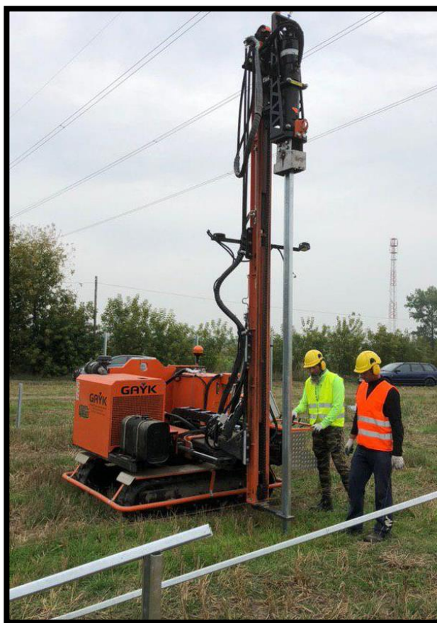
Zdjęcie 4 Montaż konstrukcji wsporczej (kafar)
