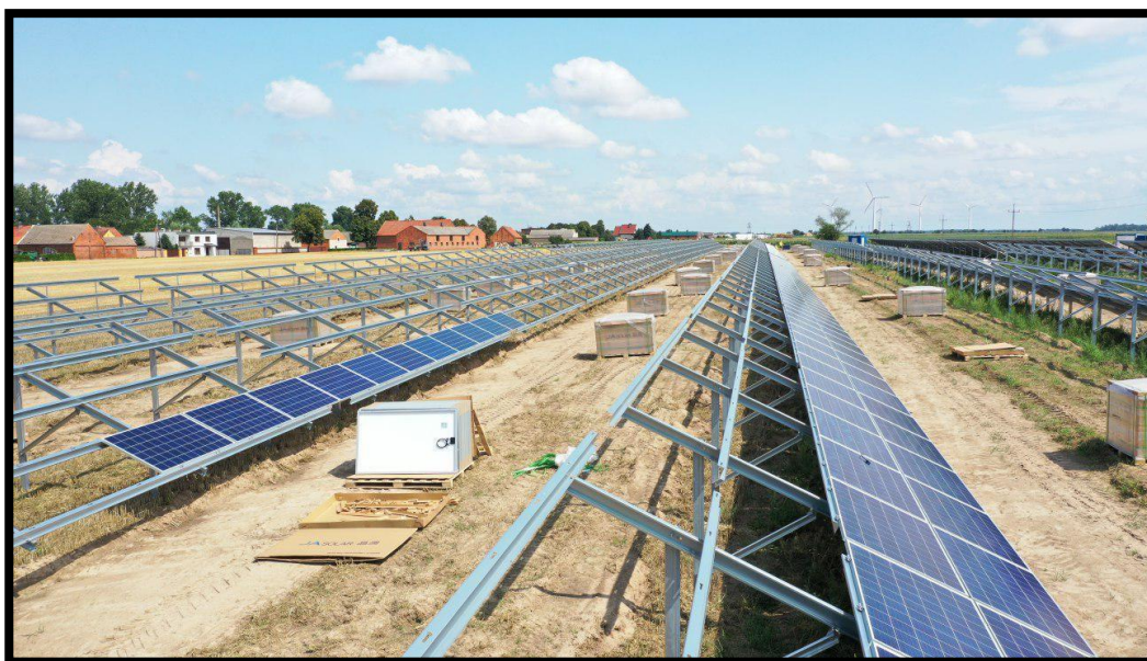
Zdjęcie 3 Konstrukcja wsporcza (farma słoneczna Ziemin, gm. Krobia)
